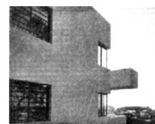
Figura 10c (1965): vista do balcão em balanço – fachada sudoeste.
